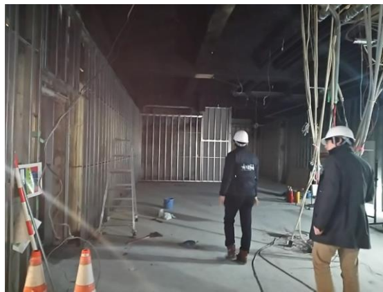
施設改修の様子
